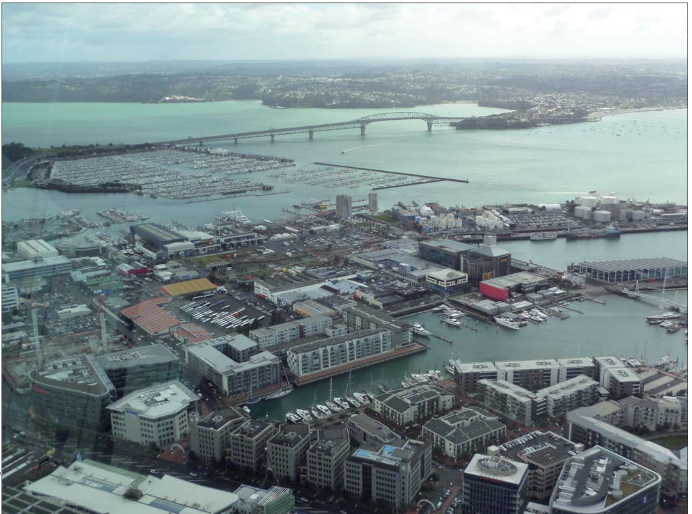
Der Hafen von Auckland mit der achtspurigen Harbour Bridge, der Straßenbrücke über den »Waitemata Harbour«
