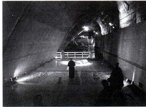
Prostor opery «Kär» ve vysokohorské přehradní hrázi
