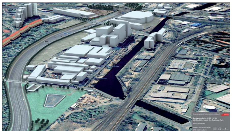
Bauabschnitt 16, Los 4, mit 650 m Länge – Ansicht von Norden
